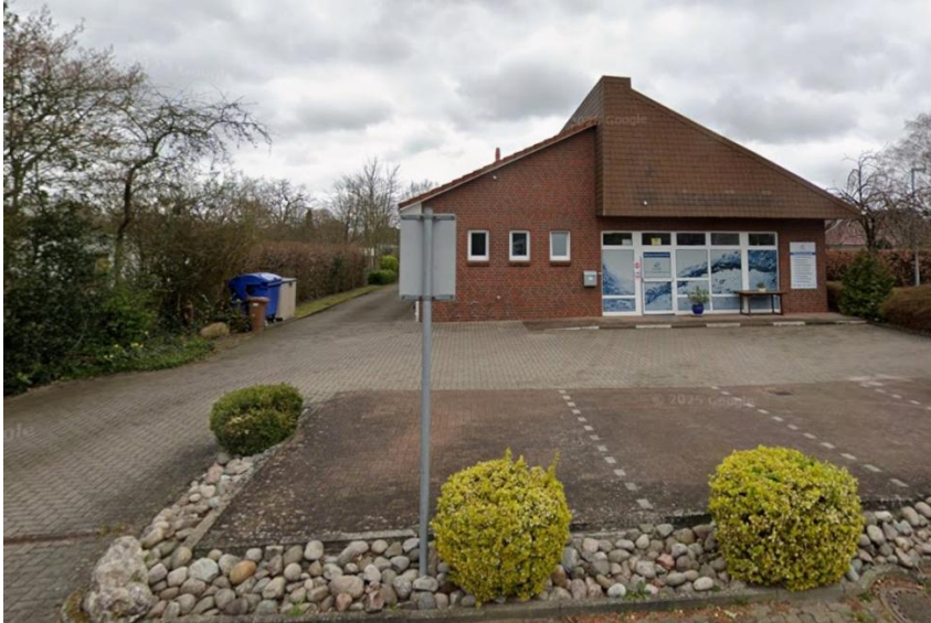
Bestandsgebäude von der Bahnhofstraße aus gesehen, links befindet sich die Ein- und Ausfahrt, parallel zur Bahnhofstraße sind Senkrechtparkplätze angeordnet.
